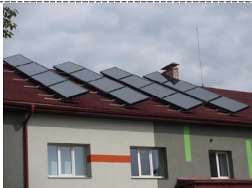
Photo 2: Installazione di collettori solari
