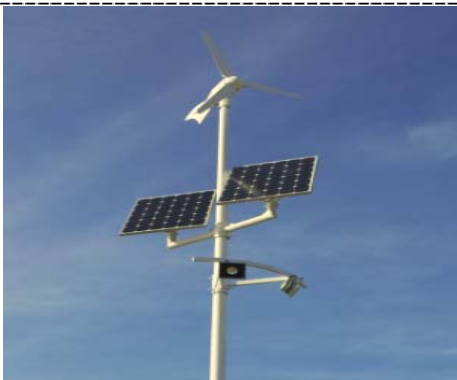
Photo 3: Installazione di sistemi ibridi eolico-fotovoltaico per l'illuminazione pubblica
