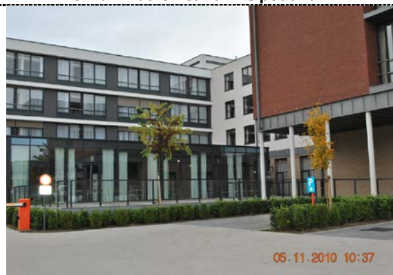
Slika 3 Zgrada EPC zajednice Londerzeel
